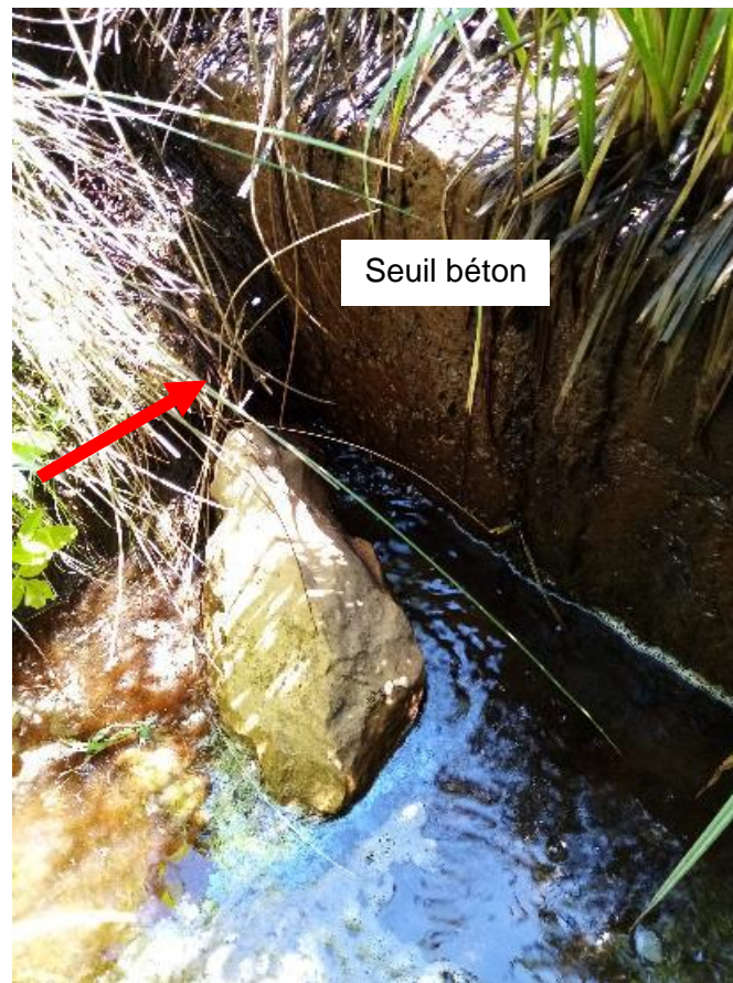
Figure 7 : Localisation de l'écoulement latéral en rive droite, été 2023
